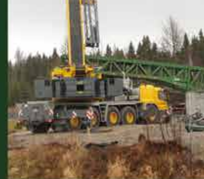
Pont de lancement temporaire (BPDL) pour l'installation des poutres
