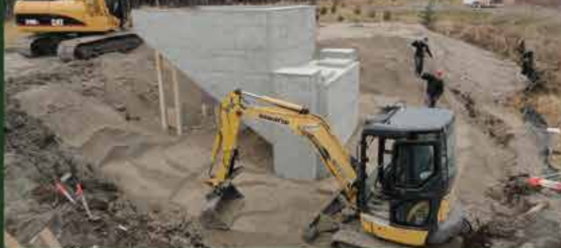
Remblaiement des culées (fondations du pont)
