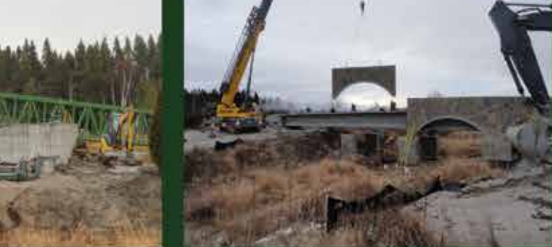
Levage des 10 panneaux préfabriqués de 12 tonnes chacun
